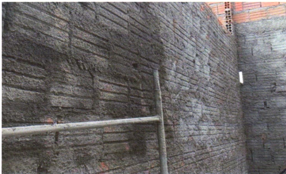
FOTO 08 - CHAPISCO APLICADO EM ALVENARIAS E ESTRUTURAS DE CONCRETO INTERNAS, COM COLHER DE PEDREIRO. ARGAMASSA TRAÇO 1:3 COM PREPARO EM BETONEIRA 400L. AF_06/2014
