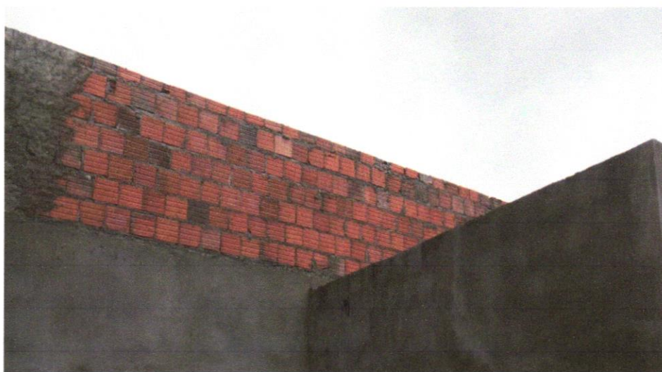
FOTO 04 -CHAPISCO APLICADO EM ALVENARIAS E ESTRUTURAS DE CONCRETO INTERNAS, COM COLHER DE PEDREIRO. ARGAMASSA TRAÇO 1:3 COM PREPARO EM BETONEIRA 400L. AF_06/2014
