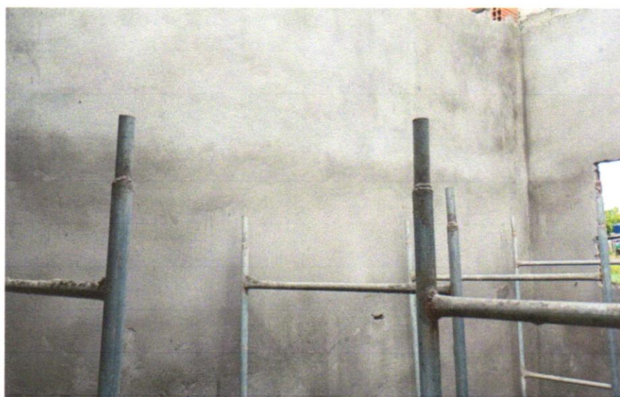
FOTO 02 – MASSA ÚNICA, PARA RECEBIMENTO DE PINTURA, EM ARGAMASSA TRAÇO 1:2:8, PREPARO MANUAL, APLICADA MANUALMENTE EM FACES INTERNAS DE PAREDES, ESPESSURA DE 10MM, COM EXECUÇÃO DE TALISCAS. AF_06/2014
